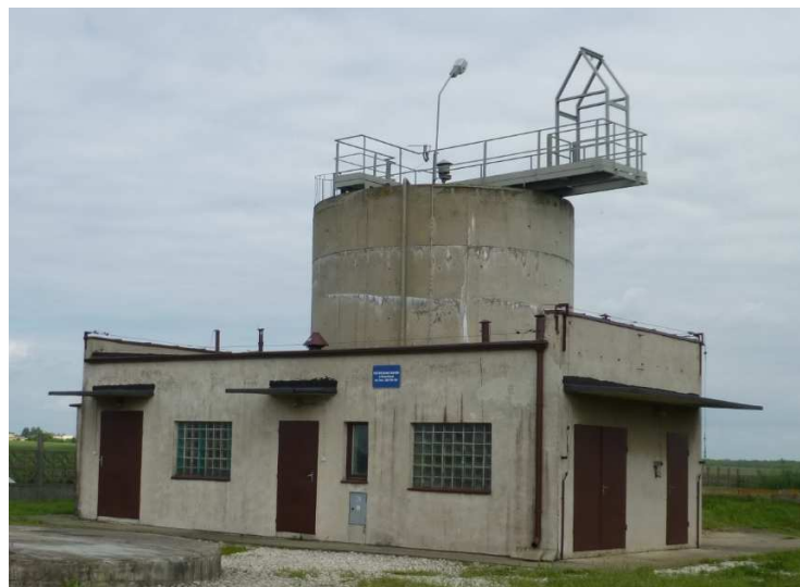
Budynek technologiczny i reaktor SBR.
