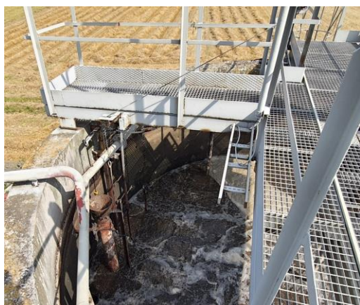
Rysunek 13. Elementy wyposażenia bioreaktora
