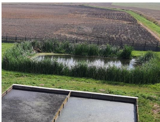
Rysunek 15. Staw stabilizacyjny ścieków oczyszczonych
