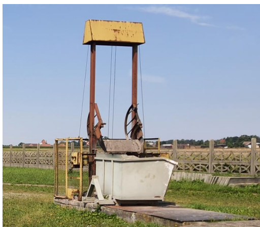
Rysunek 10. Stanowisko kraty koszowej
