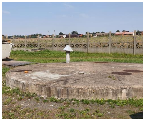
Rysunek 11. Zbiornik pompowni ścieków
