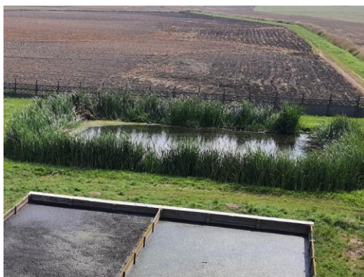
Rysunek 9. Staw stabilizacyjny ścieków oczyszczonych
