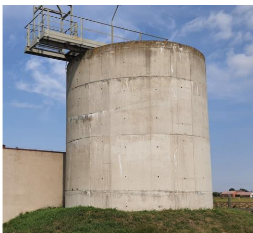
Rysunek 6. Zbiornik bioreaktora
